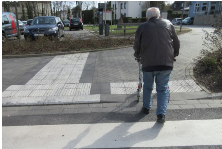
Abbildung 4-35: Differenzierte Bordhöhen
