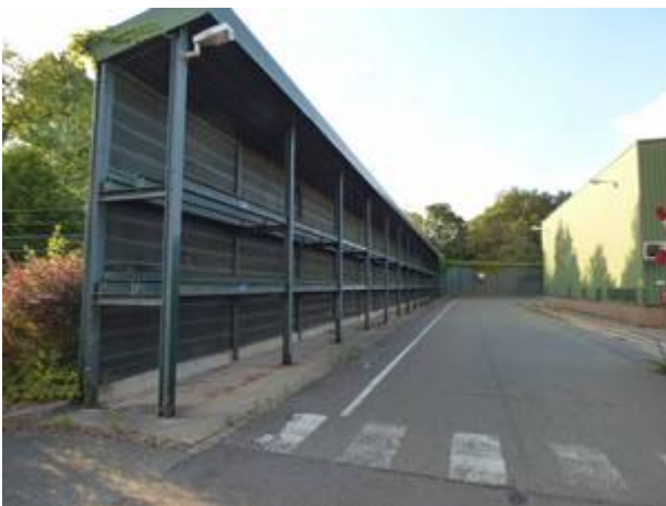
Abbildung 2: Nördliche Lärmschutzwand, Ostseite.
