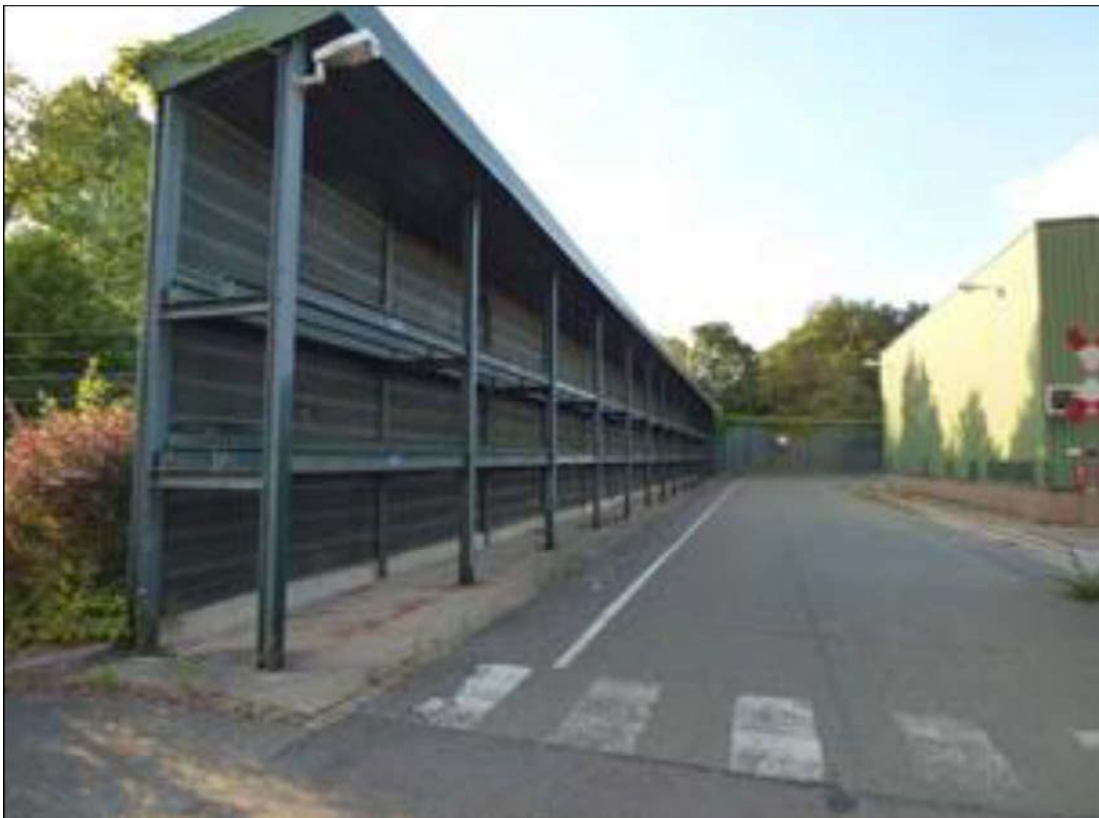
Abbildung 5: Auf dem Hochregallager werden 11 Lehmwannen befestigt
