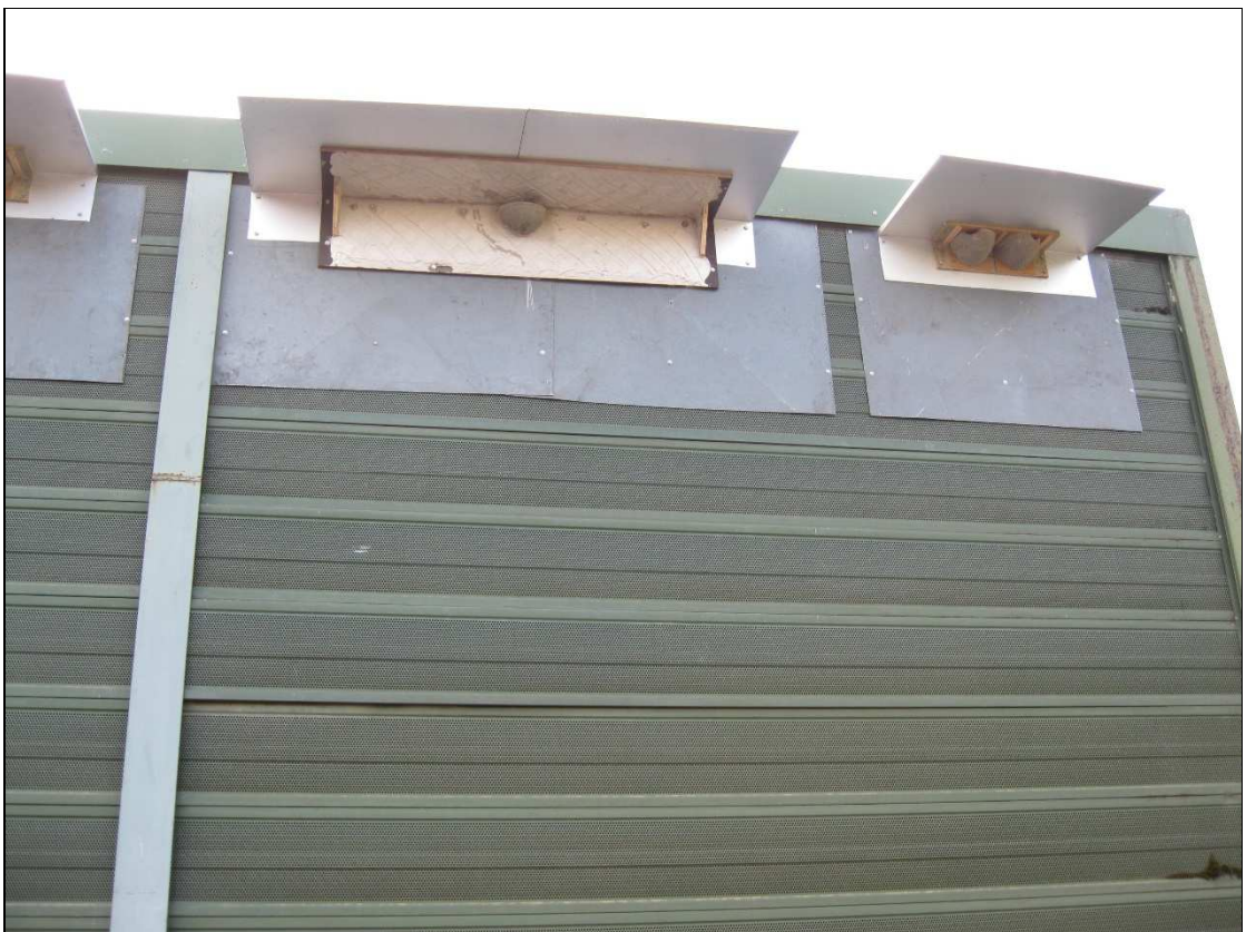
Abbildung 3: Montage der Rauch- und Mehlschwalbennester
