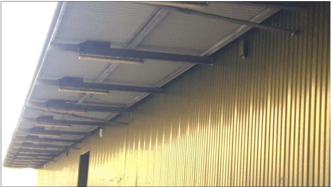
Abbildung 11: Fledermausersatzquartier an der Nordseite des Betriebsmittellagers
