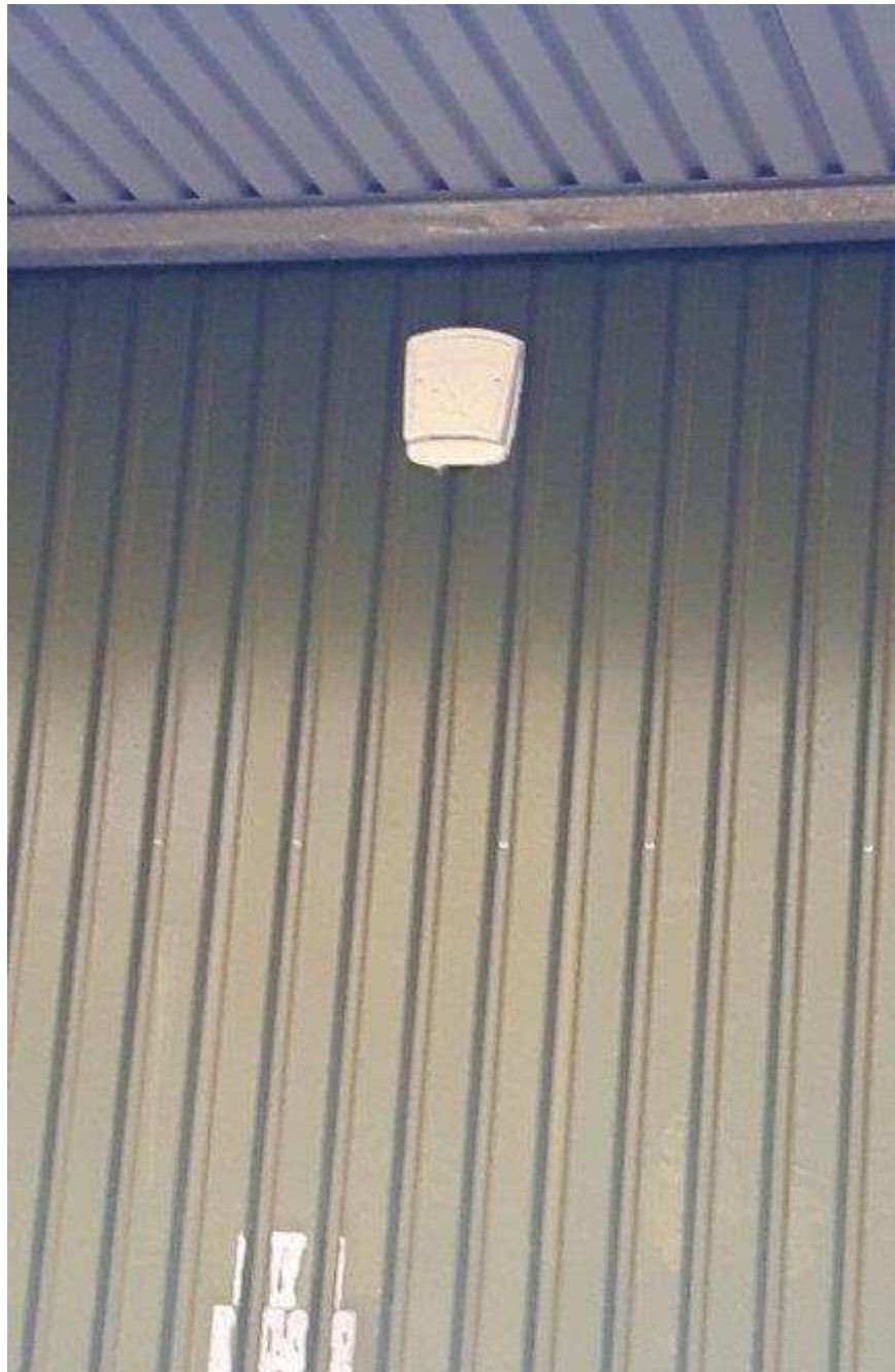
Abbildung 10: Fledermausersatzquartier an der Nordseite des Betriebsmittellagers
