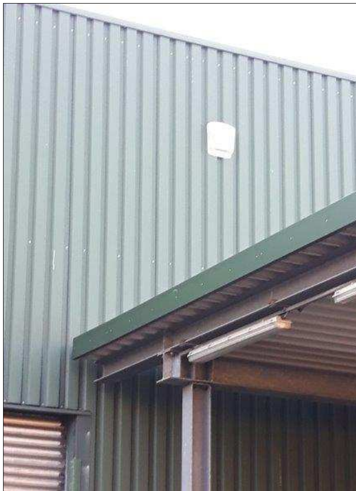
Abbildung 8: Fledermausersatzquartier an der Ostseite des Betriebsmittellagers
